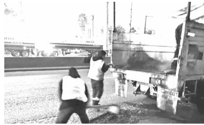
Por diversas avenidas del municipio avanzan con las obras
