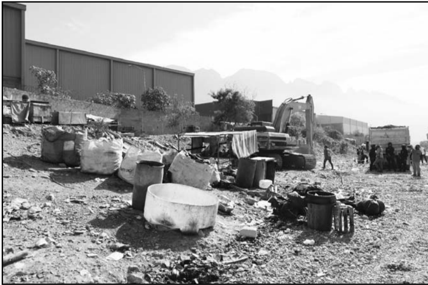
Se están haciendo trabajos en la zona del arroyo
